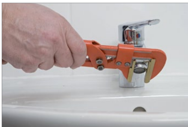
Befinden sich Kalk- oder andere kleine Partikel im Luftsprudler des Wasserhahns? Schwebstoffe können auf marode Rohrleitungen hinweisen.
