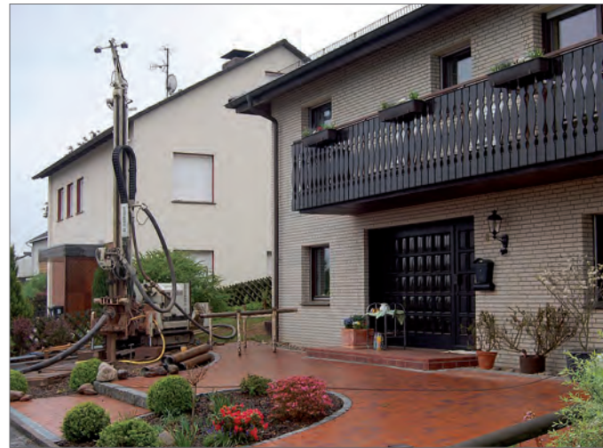
Die Nutzung der Erdwärme hängt nicht zuletzt davon ab, ob auf dem Grundstück eine Sondenbohrung möglich ist.
