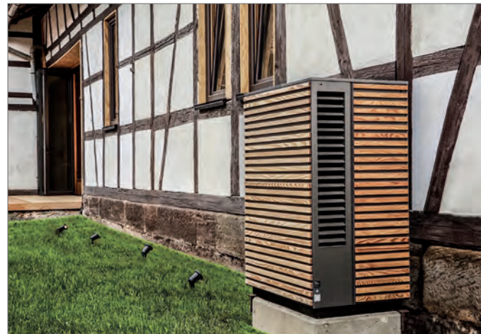
Mit der Verkleidung zwar schön anzusehen. Aber ob diese Luft-Wasser-Wärmepumpe das Fachwerkhaus stromsparend beheizen kann, sollte vorab vom Fachmann analysiert werden.
