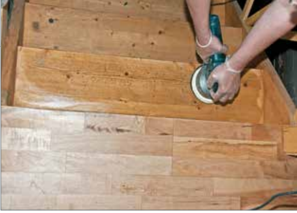
Die Maserung der Treppenstufen wird mit Pflegeöl und Schleifpad neu angefeuert
