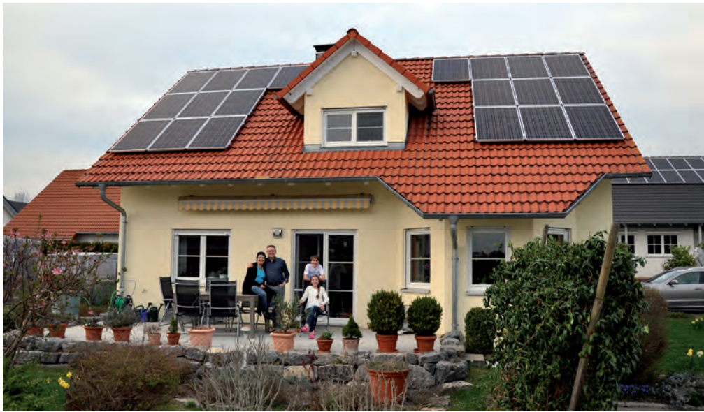
Familie Schrenk hat 2014 eine PV-Anlage mit 5,2 Kilowatt Leistung installieren lassen. 2015 konnten die vier Bewohner 24 Prozent des Solarstroms selbst verbrauchen. Das spart Energiekosten
