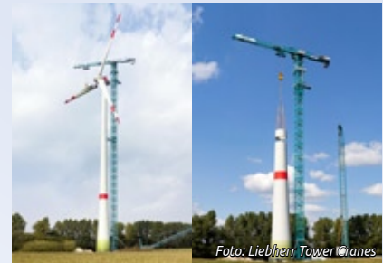
Foto: Liebherr TowerCrane
