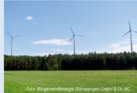
Seitenansicht Bürgerwindpark Dürrwangen
