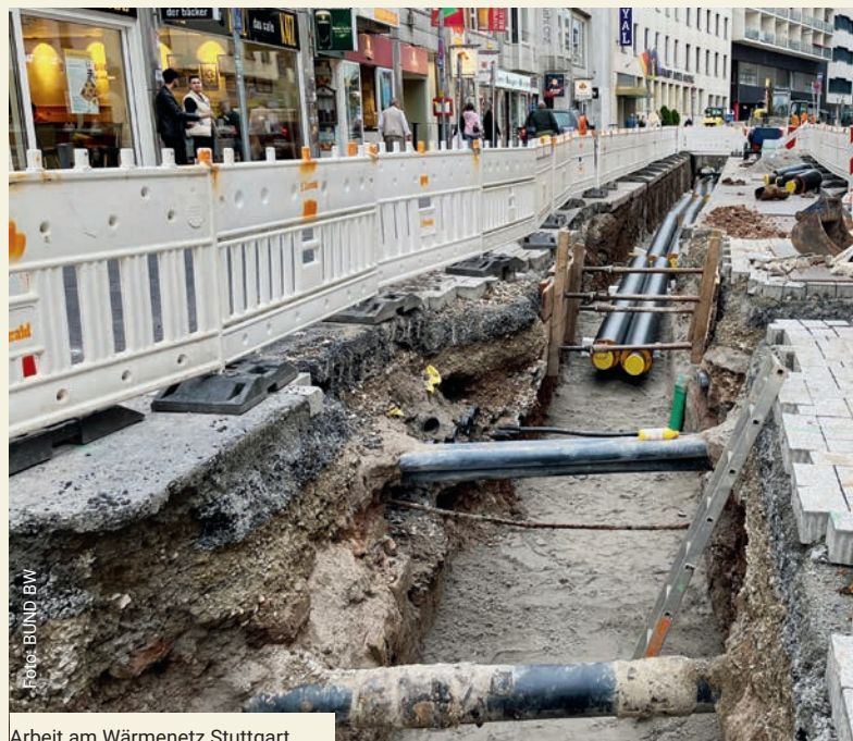
Arbeit am Wärmenetz Stuttgart
