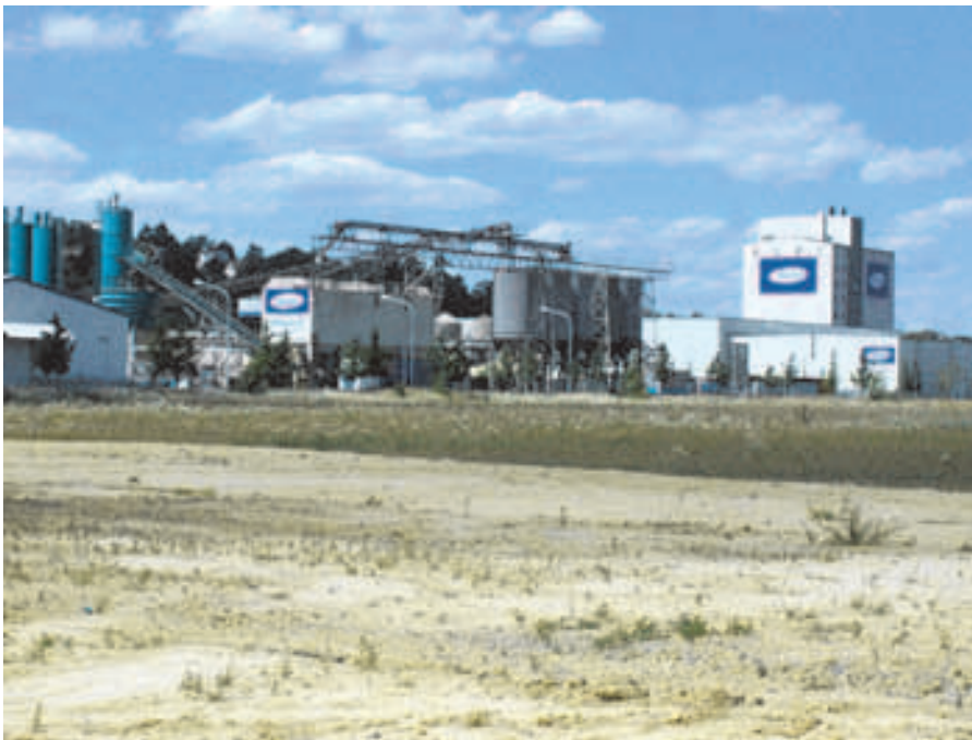
Foto unten links: Alte Industriebauten im südlichen Einfahrtsbereich in das neu erschlossene Areal. Von der über den Kanalhafen spannenden Peter-Bruckmann-Brücke aus kommend.
