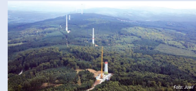
Windpark Ellern in Bau
