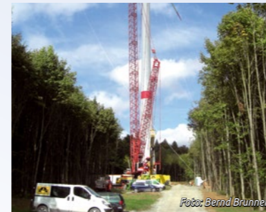
Bauphase der Windenergieanlage
