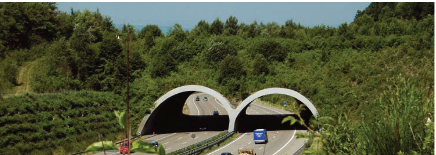
Grünbrücken sollten ausschließlich nach den Ansprüchen der Wildtiere ausgerichtet sein.
